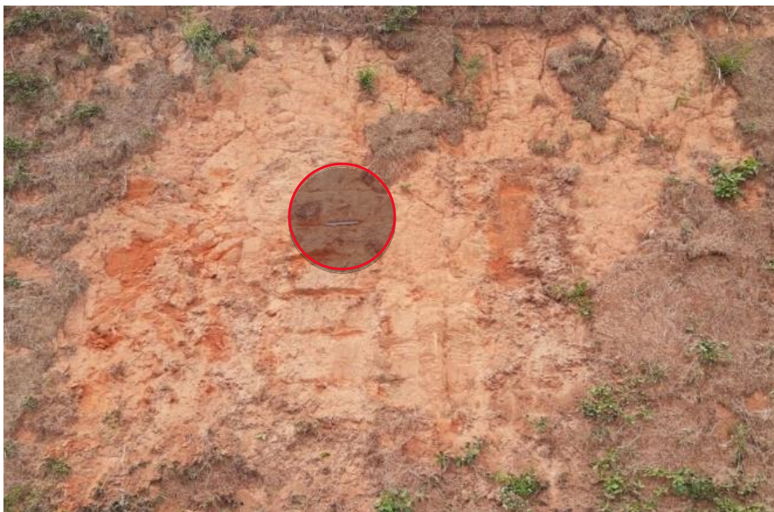
Figura 2. Talude escolhido para estudo.
